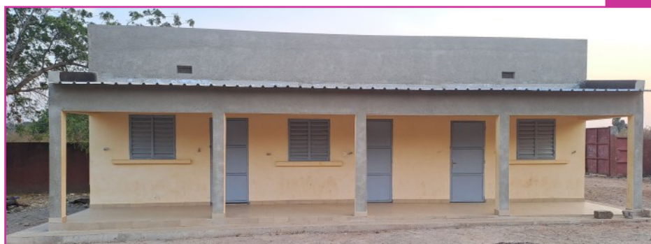
Bloc administratif à Ibel (Direction, surveillant, salle des professeurs)
